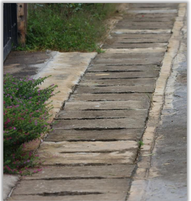
รางระบายน้ำรูปตัวยู พร้อมบ่อพัก ซอย ๑๔ บ้านข้าวแคร่
