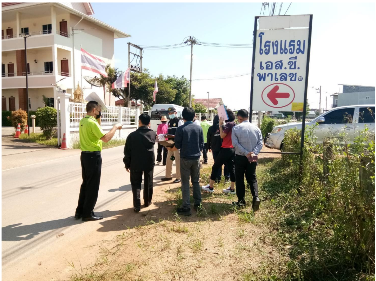
คณะกรรมการตรวจโครงการวางท่อระบายน้ำพร้อมบ่อพักปากซอยบ้านหมอวัฒนถึงหน้าโรงแรมเอสซีพาเลซ หมู่ที่ ๔
