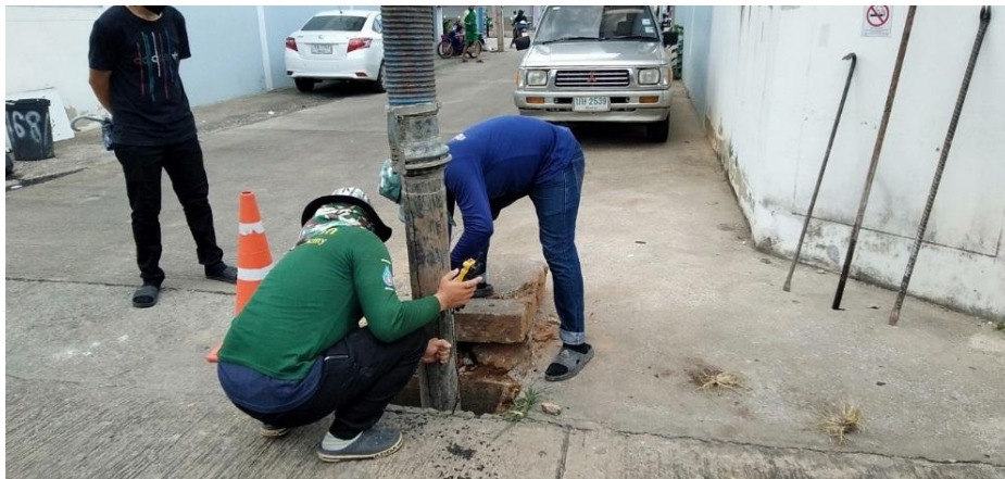
การดูแลล้างท่อของแต่ละพื้นที่ในเขตตำบลบ้านดู่ เพื่อแก้ไขปัญหาหน้าเสียวและไขมันอุดตันที่ระบายน้ำ
